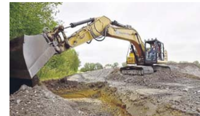
Es geht los: Die Vorarbeiten für das Fünf-Millionen-Euro-Projekt auf dem Westfalia-Vereinsgelände laufen.
