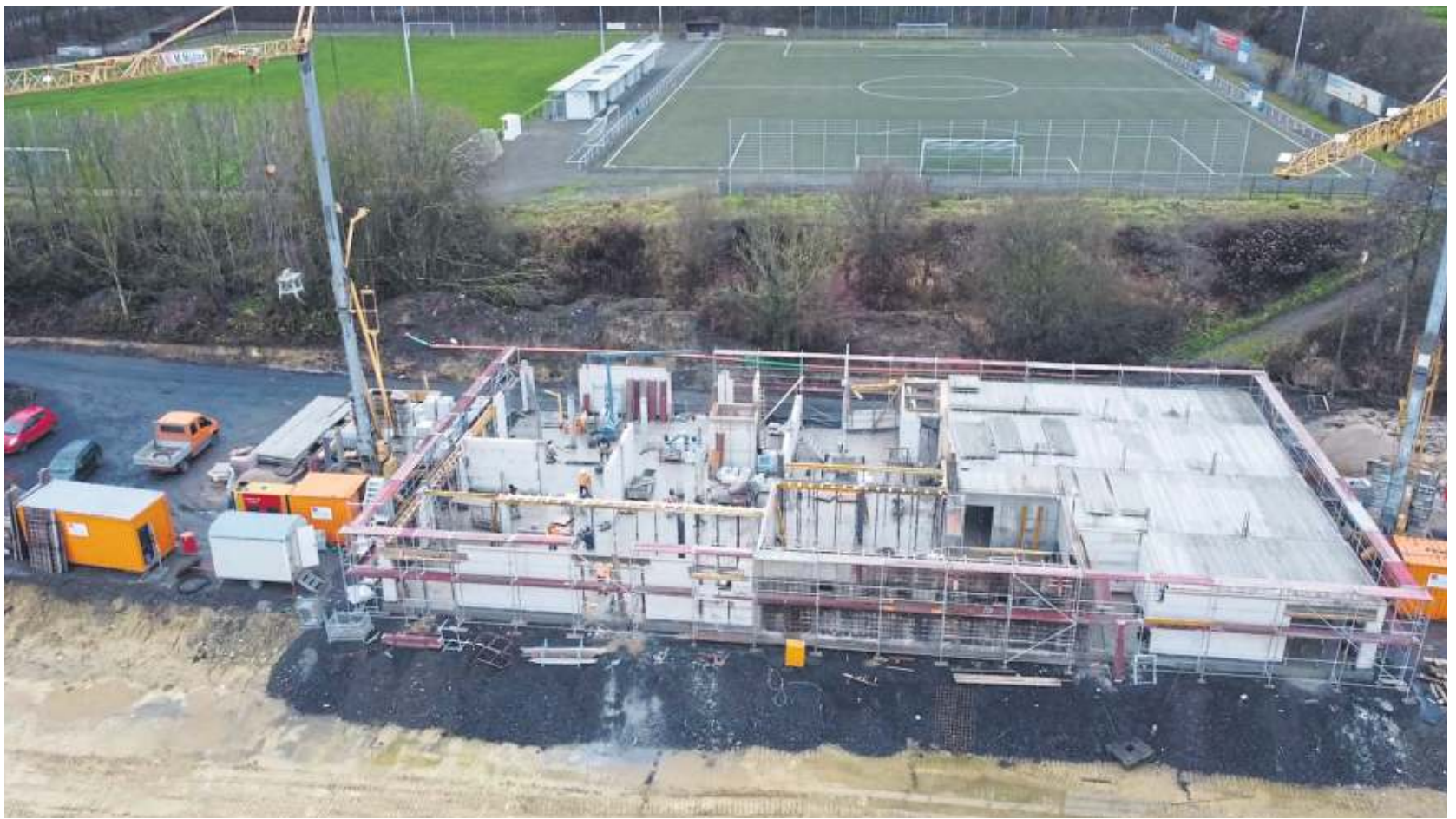
Die ersten Decken werden gezogen: Die Räume der neuen Sport-Kita im Neubau des SV Westfalia Rhynern zeichnen sich bereits ab.
